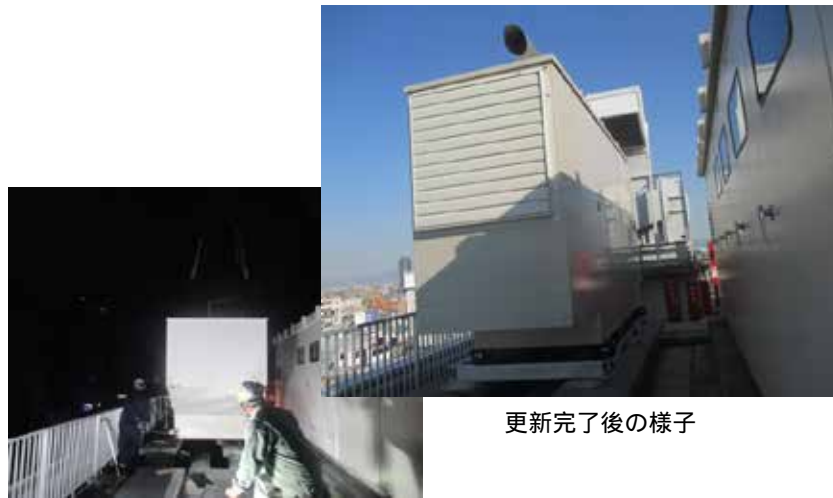
旧発電機撤去の様子
