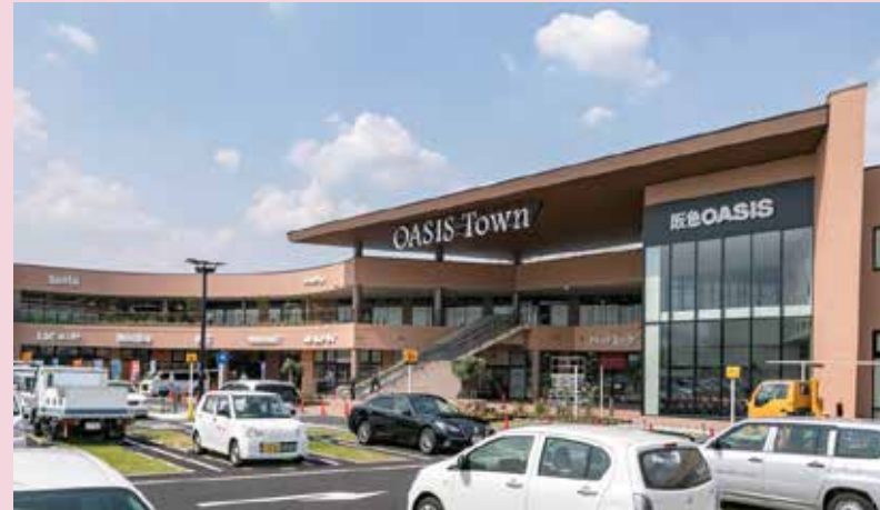
オアシスタウン伊丹鴻池（敷地）
