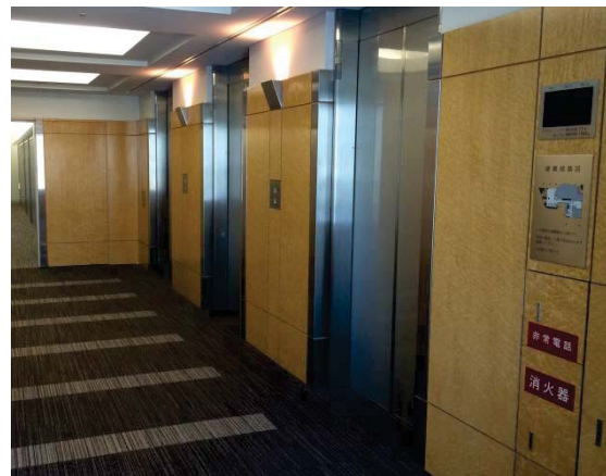
各階エレベーターホール
