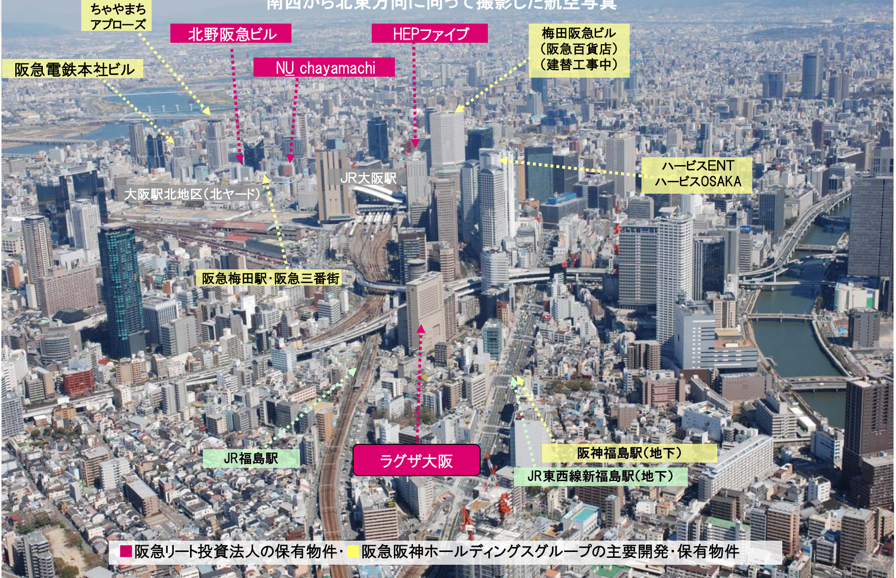
南西から北東方向に向って撮影した航空写真
