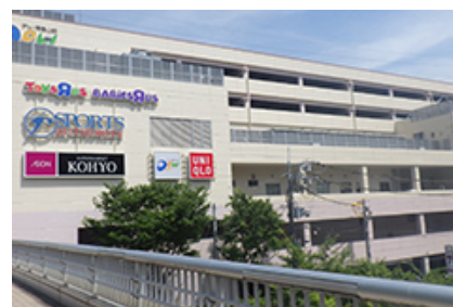
デュー阪急山田の外壁工事
