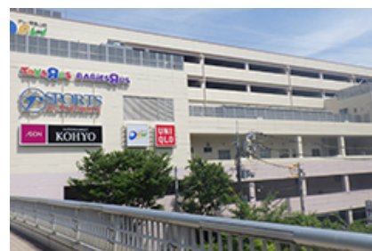
デュー阪急山田の外壁工事
