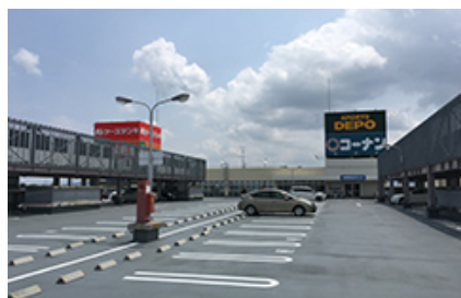
高槻城西ショッピングセンターの 屋上防水工事
