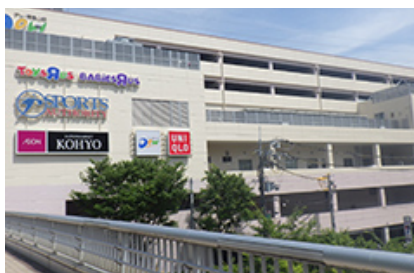
デュー阪急山田の外壁補修工事
