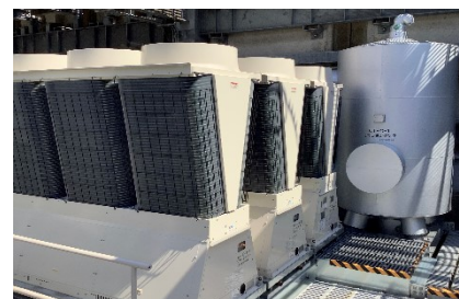
ラグザ大阪の熱源更新工事
